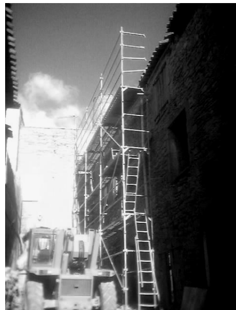
En plein travaux...
