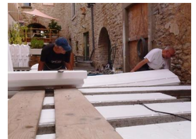
Réalisation du plancher isolant avec Alfonso
